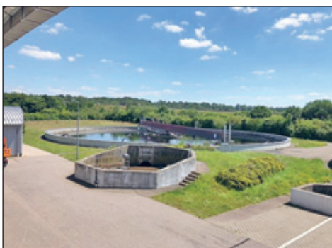
Bild 2: Das Nachklärbecken Fotos: WAD GmbH
