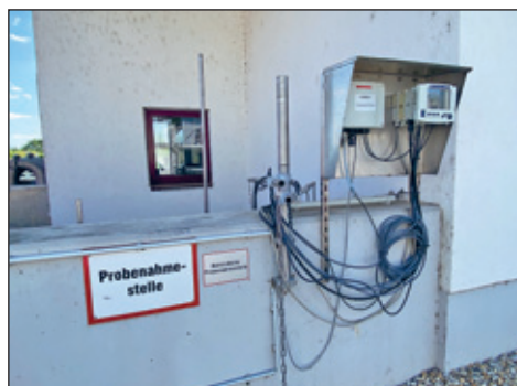
Bild 3: Probenentnahmestelle für die finale Kontrolle des Wassers...
