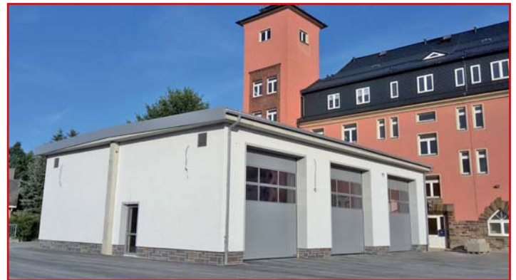
Die angebaute Fahrzeughalle kurz vor der Fertigstellung, noch ohne Außenlampen
