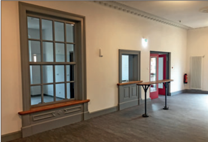
Aufgearbeitete historische Bestandselemente im Eingangsfoyer: Gepäckaufgabefenster sowie Fahrkartenschalter mit Ablagetisch
