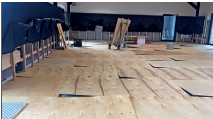
Verlegung Sportboden und Anbringung Prallschutz-Unterkonstruktion
