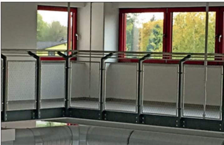
Fertiggestelltes Brüstungsgeländer mit pulverbeschichteten, anthrazitfarbenen Geländerpfosten, transparenter Edelstahlnetzfüllung und Edelstahlhandlauf im Bereich der Empore
