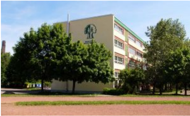
Außenansicht der Oberschule am Steegenwald
