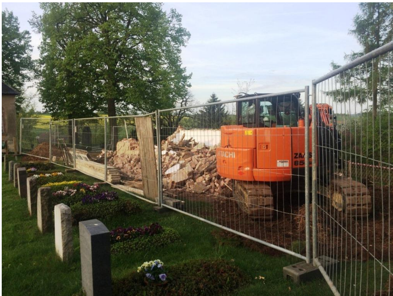
Abbruch der bestehenden Trauerhalle
