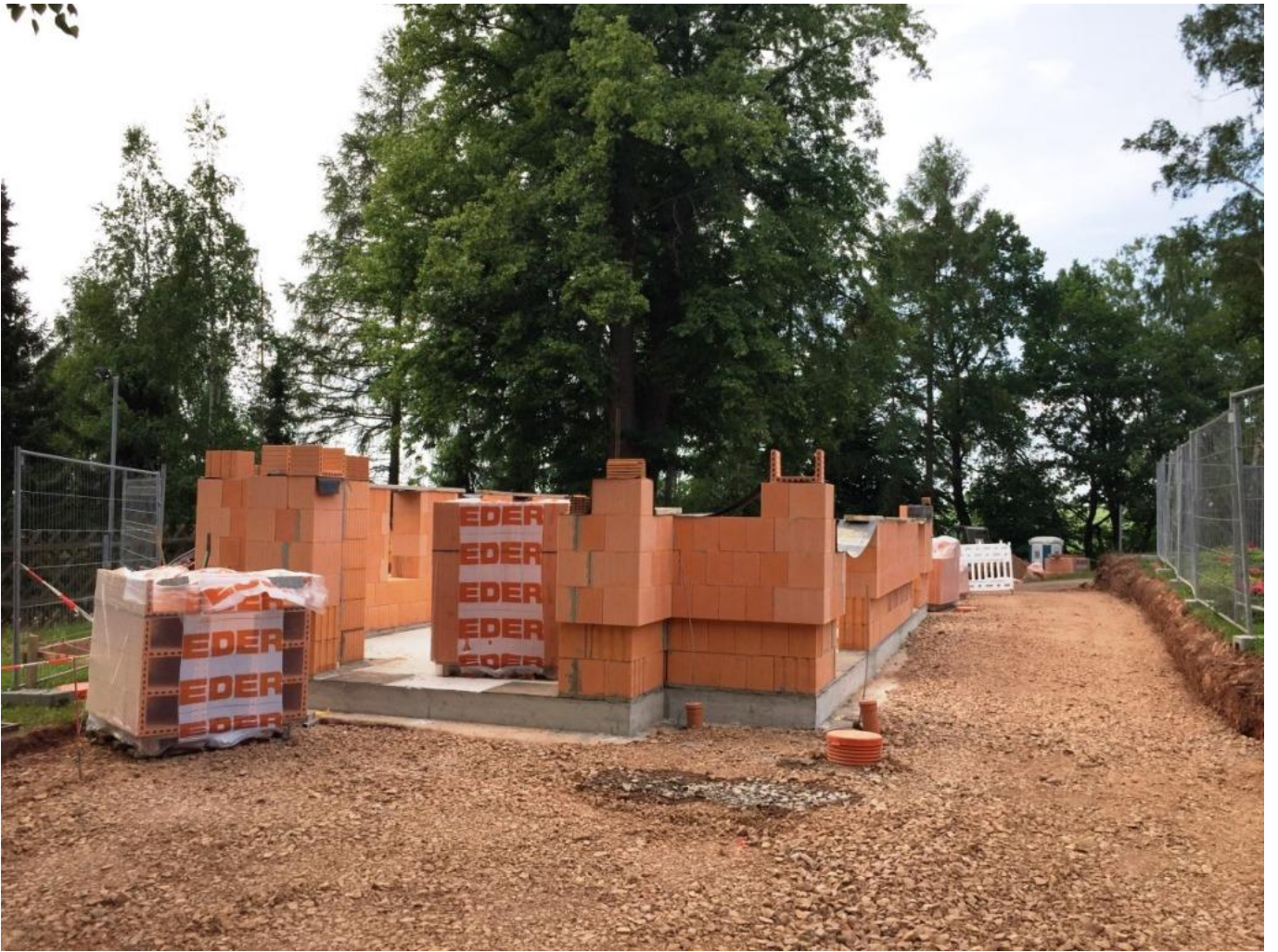
Fertigstellung Bodenplatte und Herstellung der Umfassungswände
