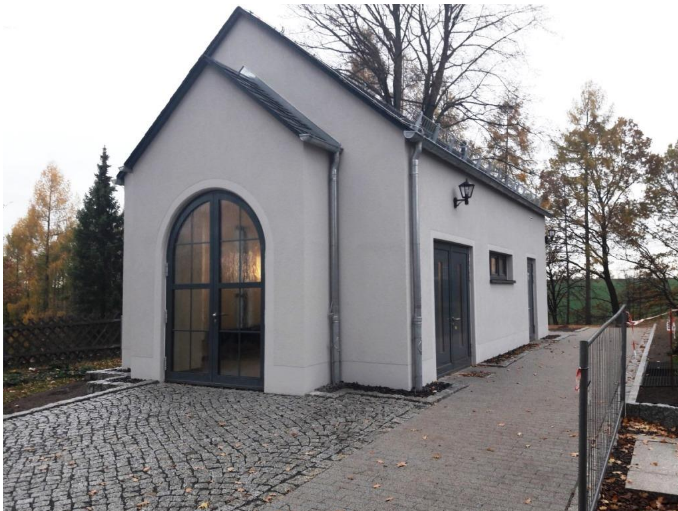
Neubau Trauerhalle auf dem Friedhof in Kirchberg am 13.11.2018 - Barrierefreie Zugänge für Trauersaal und Außentoilette
