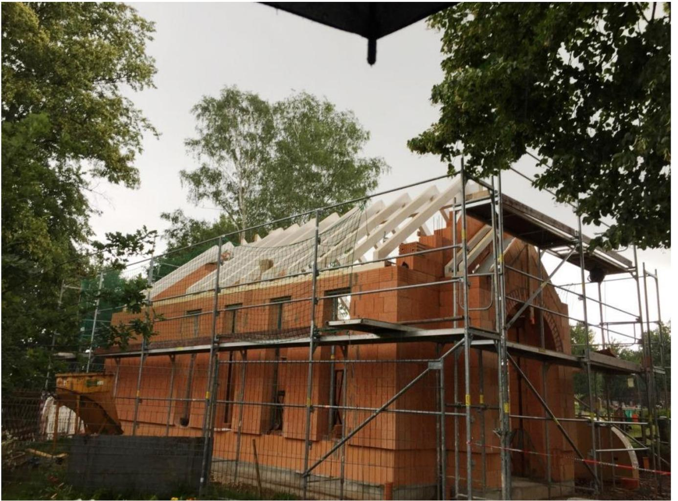
Rohbauarbeiten fertiggestellt, Zimmererarbeiten (Dachstuhl in Ausführung)
