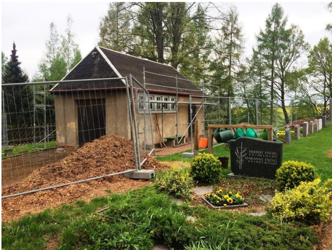
Beginn zur Maßnahme vor Abbruch Trauerhalle Kirchberg April 2018
