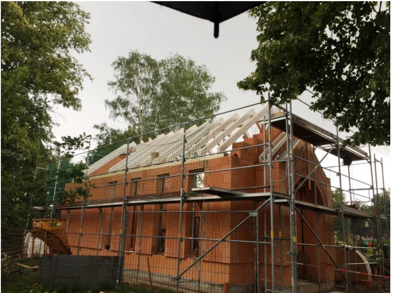
Rohbauarbeiten fertiggestellt, Zimmererarbeiten (Dachstuhl in Ausführung)
