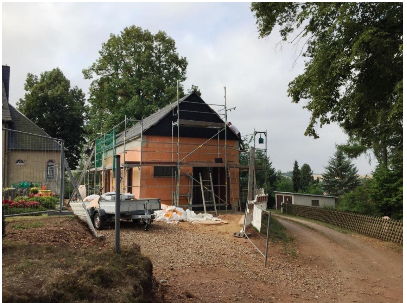
Dachdeckerarbeiten in Ausführung (schwarze Kunstschieferendeckung entsprechend Forderungen der Denkmalschutzbehörde)
