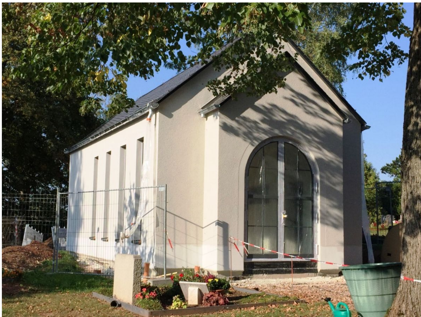
Neubau der Trauerhalle, Außenputz fertiggestellt, Gerüstbau erfolgt, Fenster-, Tür- und Torelemente eingebaut
