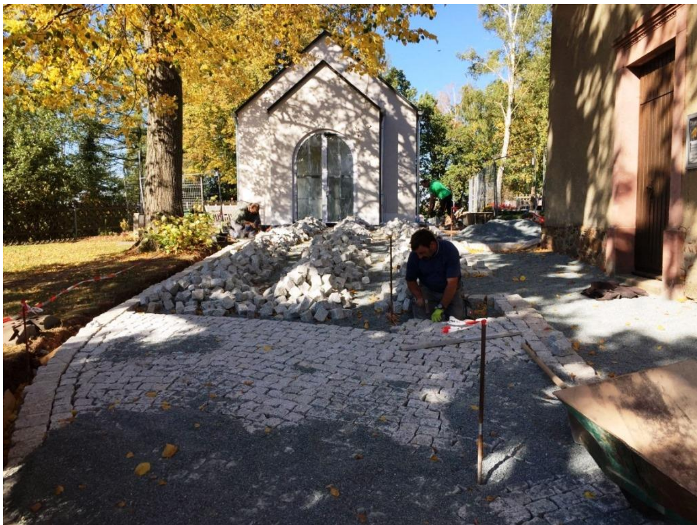
Die Zuwegung wird erneuert
